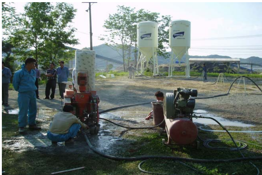
그림 23. 장비 설치 완료 장면
