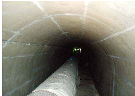
사진 2.3 철근콘크리트구조물의 표면 열화상황
