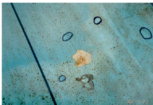
사진 2.4 방수·방식공사에서의 열화상황
