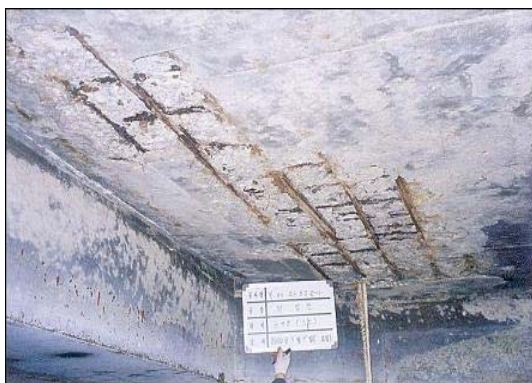
사진 2.1 철근콘크리트구조물의 철근부식 상황
