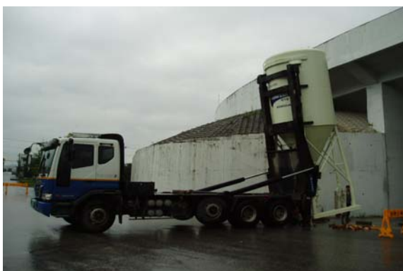
(e) 사일로 운반 및 설치
