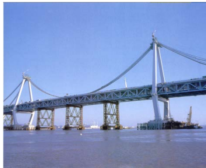
[장대교량 하부기초 보강]
