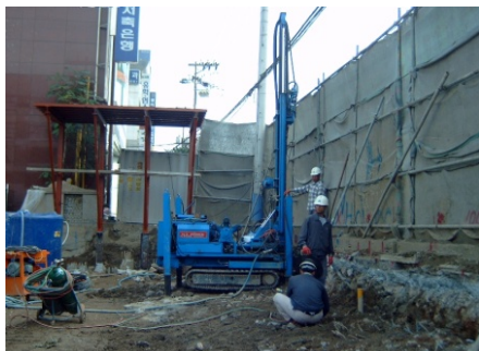
[신축건물 가시설 배면차수 보강]
