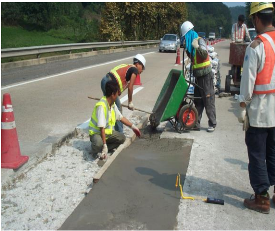
긴급 도로 보수
