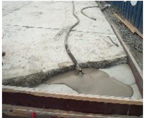
파손 콘크리트 긴급 보수
