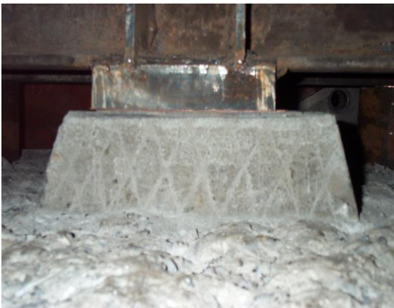
기계기초 패드 작업
