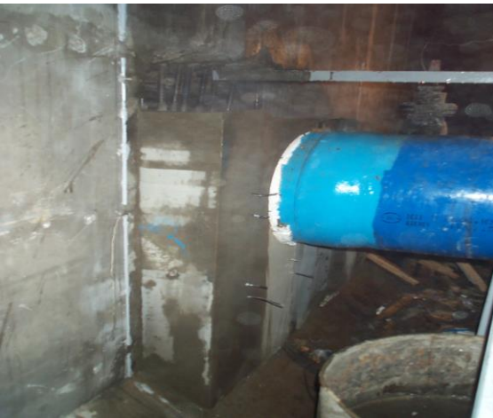
배수관 연결부 보강
