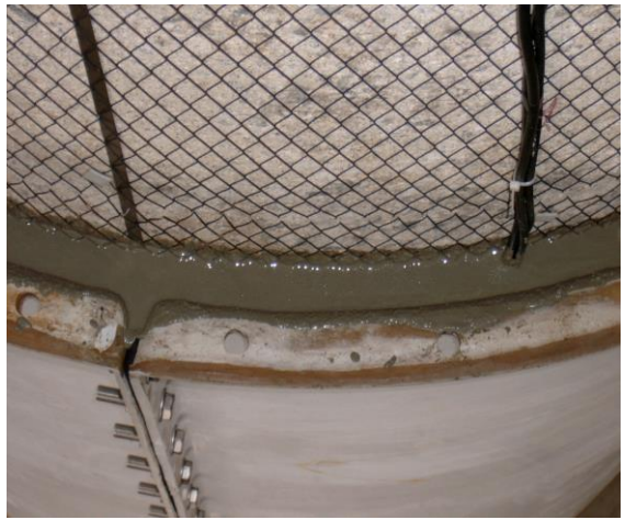
콘크리트 기둥 보강
