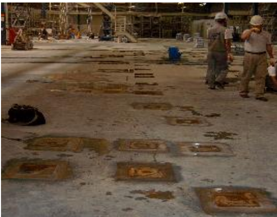
로봇 plant 기계 기초
