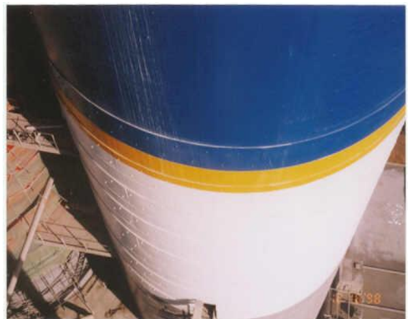
Silo 보수 보강
