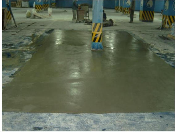
주차장 바닥 보수 보강
