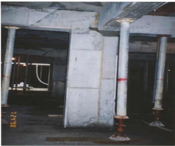
콘크리트 기둥 보수
