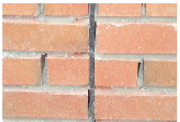
신축줄눈(Expansion joint) 설치
