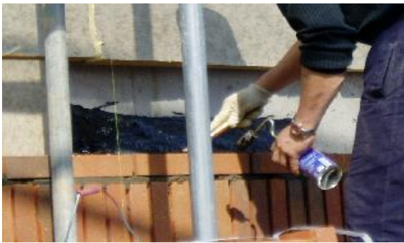
배수시설(Flashing) 설치
