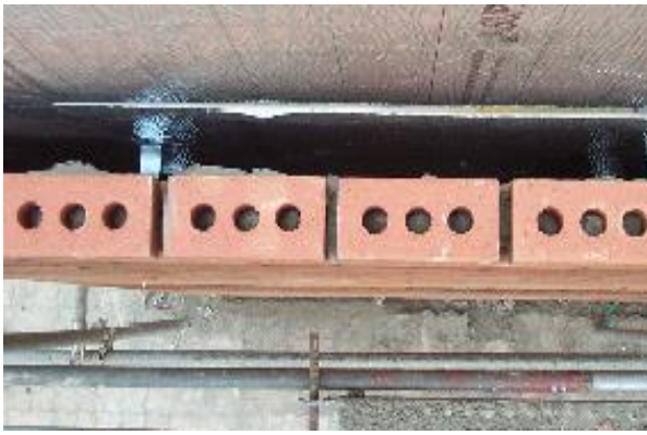
중공벽(Cavity wall) 설치
