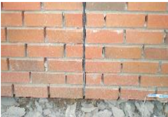
신축줄눈(Expansion joint) 설치
