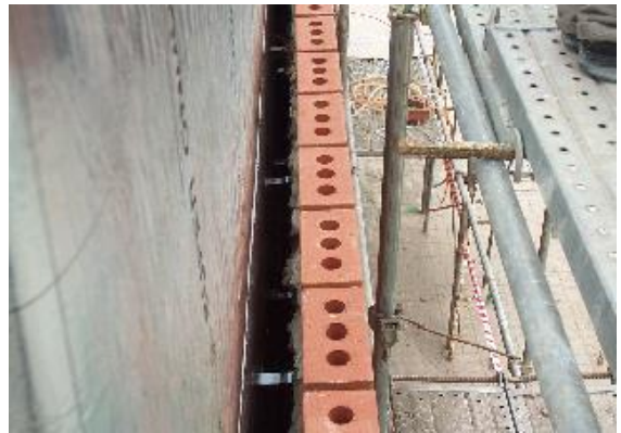
중공벽(Cavity wall) 설치
