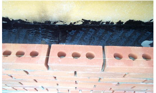
배수시설(Flashing) 설치
